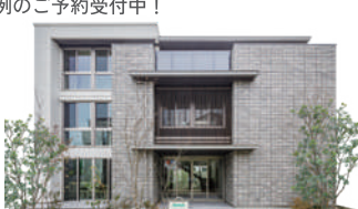
비에나 【工法/鉄骨プレハブ】
